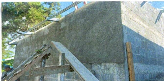
Foto 5: CERNIDO DE PAREDES.
