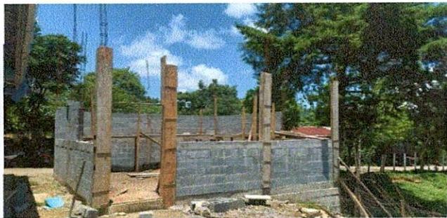
Foto 3: TRABAJO DE COLUMNAS.
