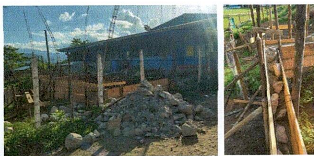
Foto 2: MURO DE CONTENCION.
