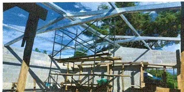
Foto 4: INSTALACION DE ESTRUCTURA METALICA Y TECHO CON LAMINA TROQUELADA.
