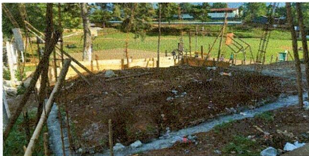
Foto1: REALIZACION DE CIMENTOS.
